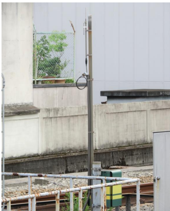
TC 型列車接近警報装置送信局と空中線（アンテナ）
