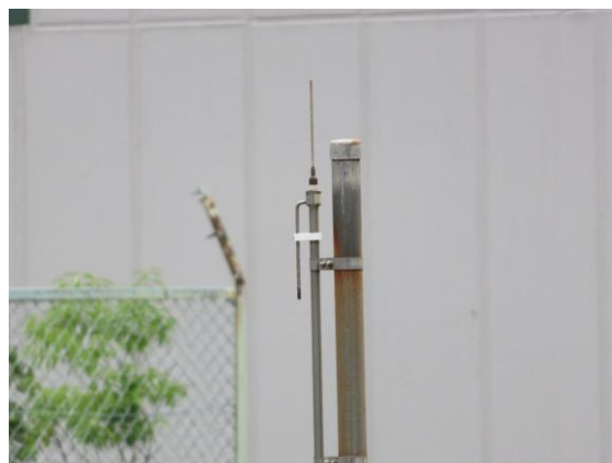
吉祥寺駅高尾方の TC 列警送信局のアンテナ部
